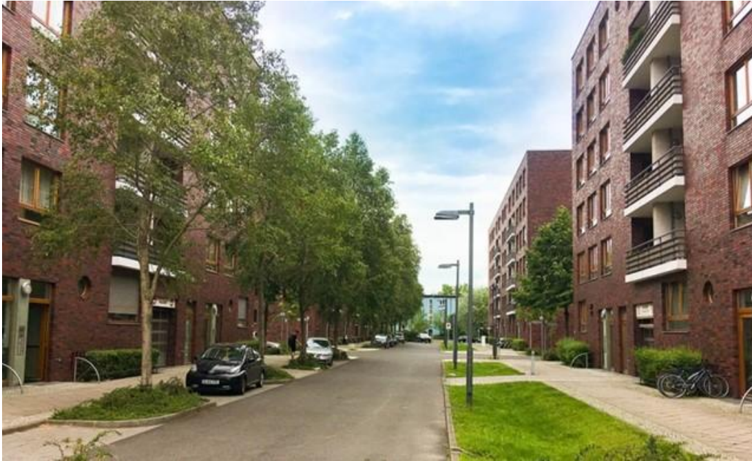
MƯƠNG BÊN ĐƯỜNG THẨM VÀ GIỮ NƯỚC
